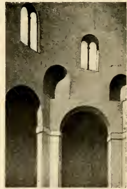
Fig. 121 — Veduta del poligono interno di San Vitale a Ravenna (a. 526-547)
